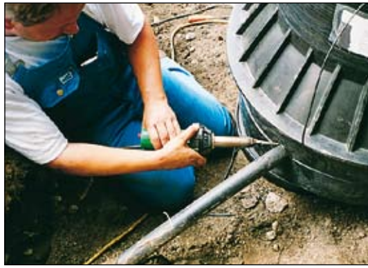
Energie AG Oberösterreich: Welding of elements
