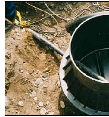
Energie AG Oberösterreich: Injection
